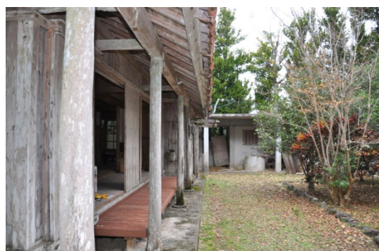
③北側雨端と濡縁 南側にも雨端が設けられており、雨端柱ぎりぎりまで濡縁が設置されている。
