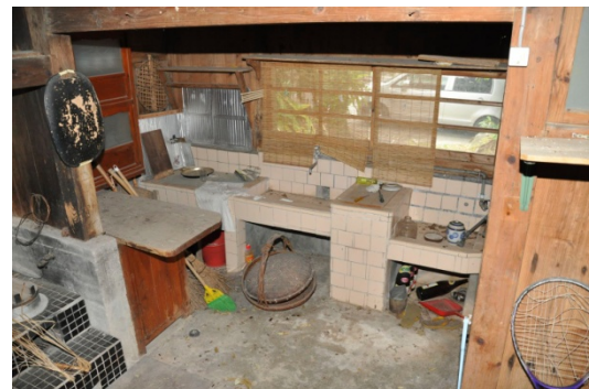
⑦台所 かまどがあり、現在でも使用可能。かまど前は板間に、流しや棚の前は土間になっている。
