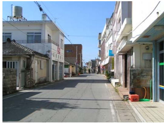
【植栽スペースのない市街地景観】
