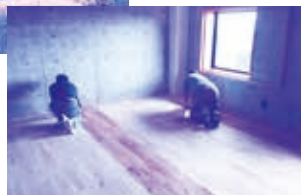
△ワックス掛け作業の様子
