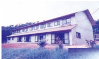
△本館施設の様子 (2019.6月撮影)
