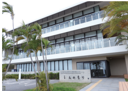
▼写真：久米島町複合型防災・地域交流センター
