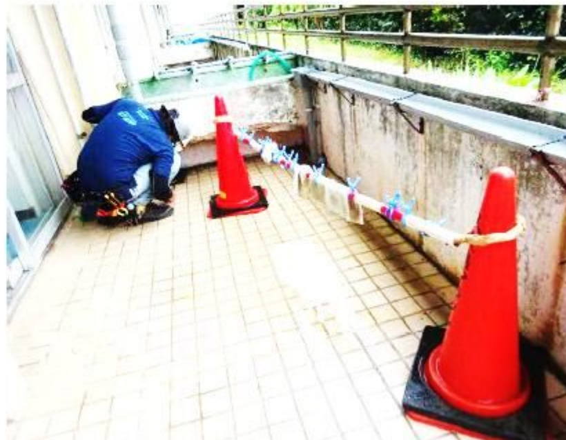
〈排水溝の修繕工事〉
