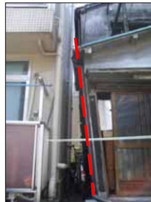
柱の変形が著しく崩壊の危険がある例
