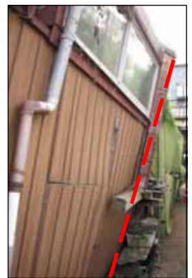
柱の変形が著しく崩壊の危険がある例
