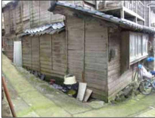
外壁が裸木造の例
