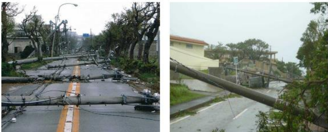
写真－1 台風による電柱倒壊状況
