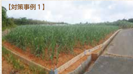
赤土流出防止板の設置
