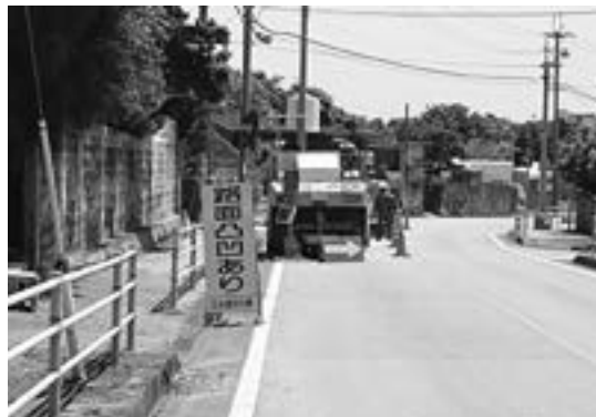
県道上江洲地区道路
