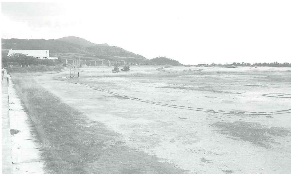
久米島多目的公園整備予定地
