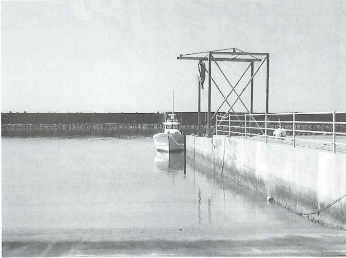
嘉手苅船揚場の荷揚施設
