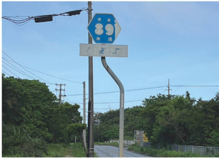
老朽化と剥離が目立つ標識(山城)
