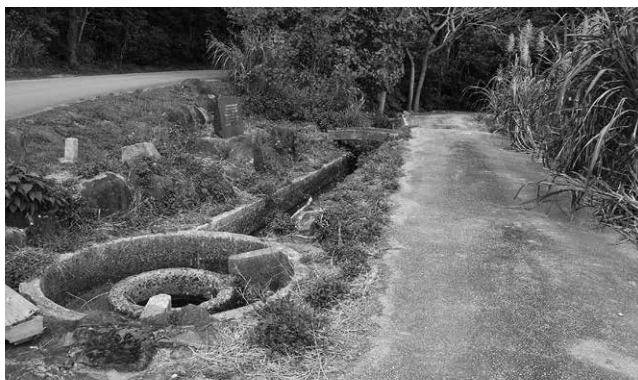
西銘導水路一部分
