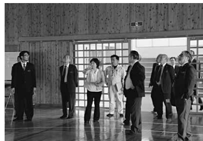
体育館の雨漏り確認
