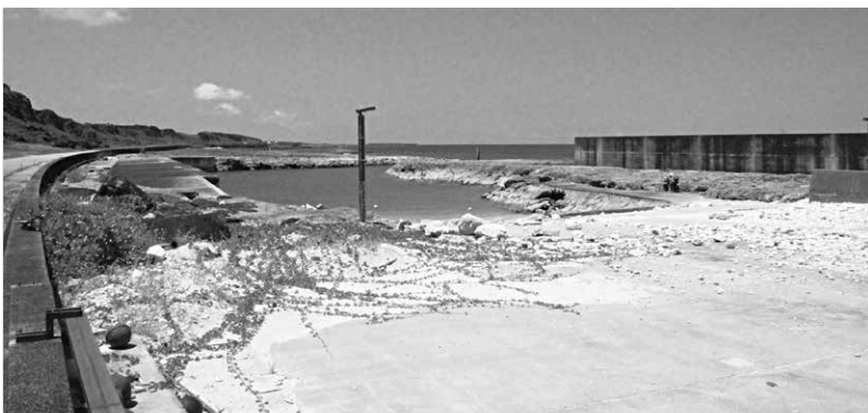
未整備な具志川漁港
