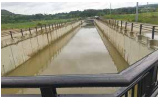
三面コンクリートの銭田川
