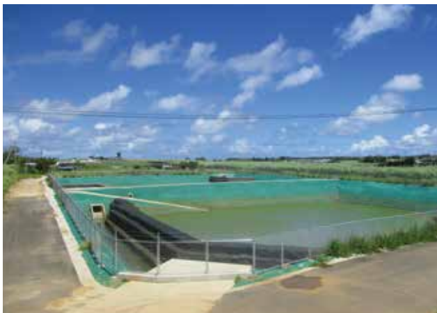
清水第1地区1号沈砂池
