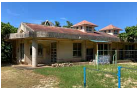
有効利用が提案された園舎
