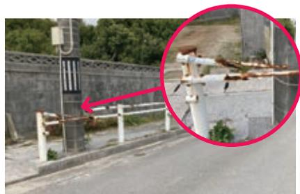
儀間地内設置のガードパイプ老朽化によって欠落し危険な場所となっている
