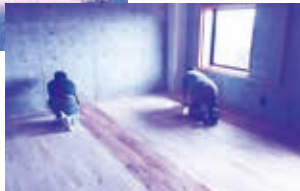
△ワックス掛け作業の様子
