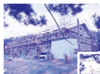
△本館工事現場の様子
