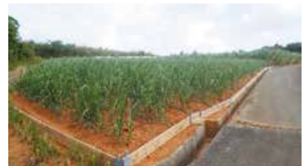
【対策事例1】赤土流出防止板の設置
