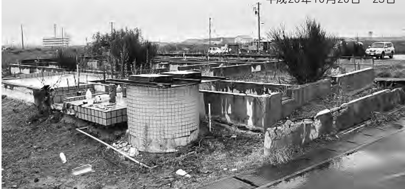
津波に流された跡の住宅
