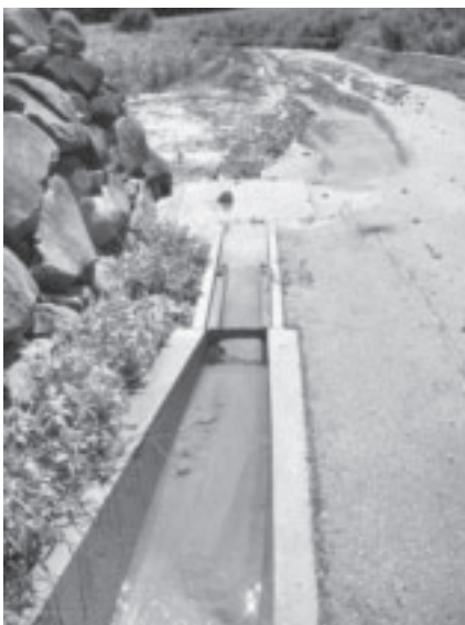
オーバーフローした側溝
