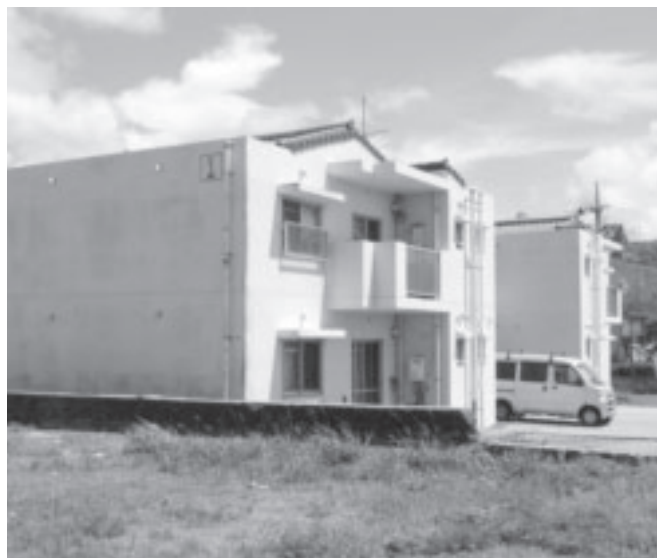
美崎団地A棟B棟
