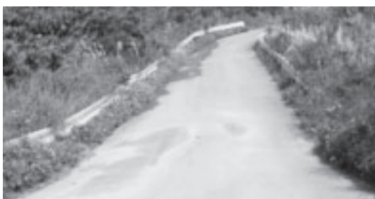
路面劣化などで危険な状態の儀間1号線
