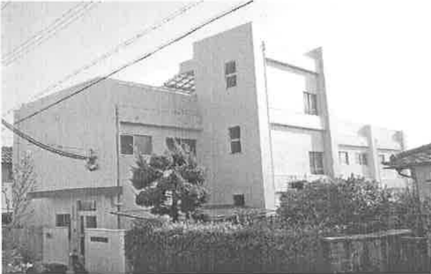
(平成28年7月寮外壁改修工事実施)
