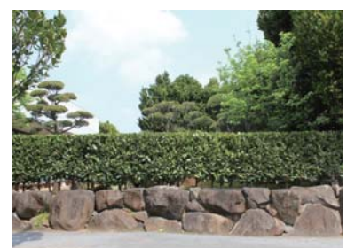
久米島石を活用し、石垣の高さを低く抑えた石垣と生垣（真謝集落）
