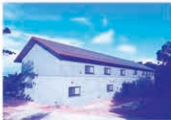
△建物全体の様子
