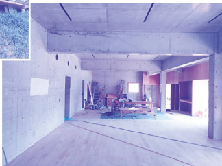
△本館施設1階多目的スペース
