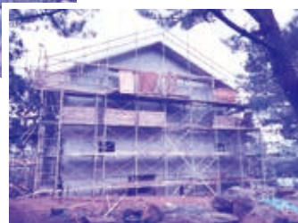
△本館工事現場の様子
