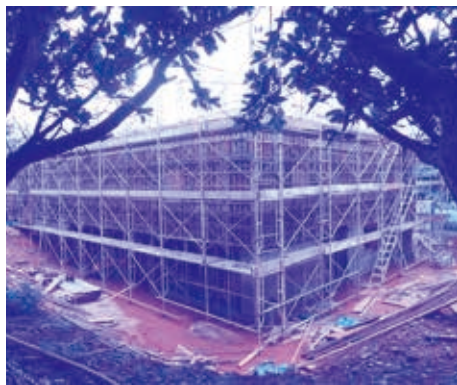
△本館工事の様子
