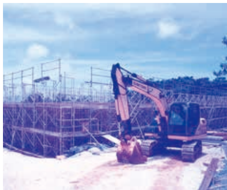
△本館工事の様子
