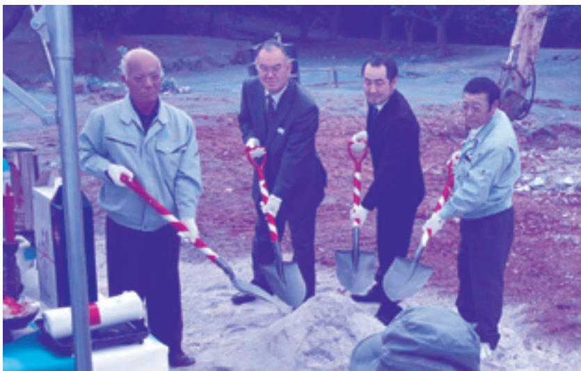
銭田森林公園にて「風の帰る森 施設本体 新築工事」起工式
