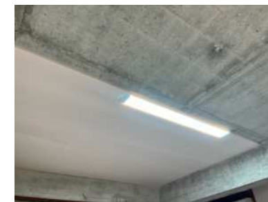
断熱材直貼り
