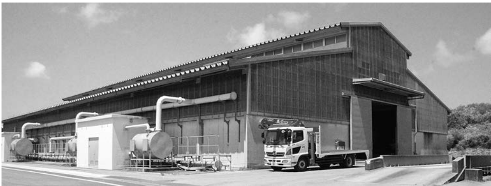
(堆肥センター)
