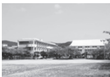
跡地利用が検討されている久米島中学校
