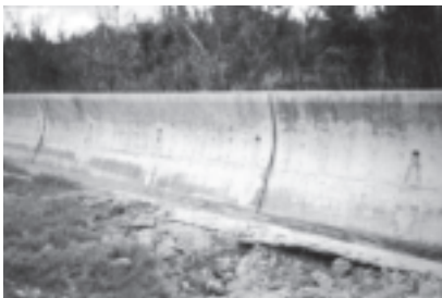
コンクリート護岸 (シンリ浜)
