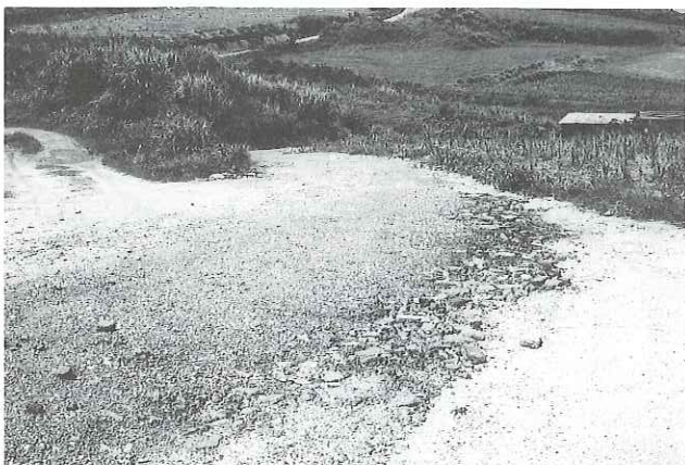
アスファルト殻により応急補修された道路
