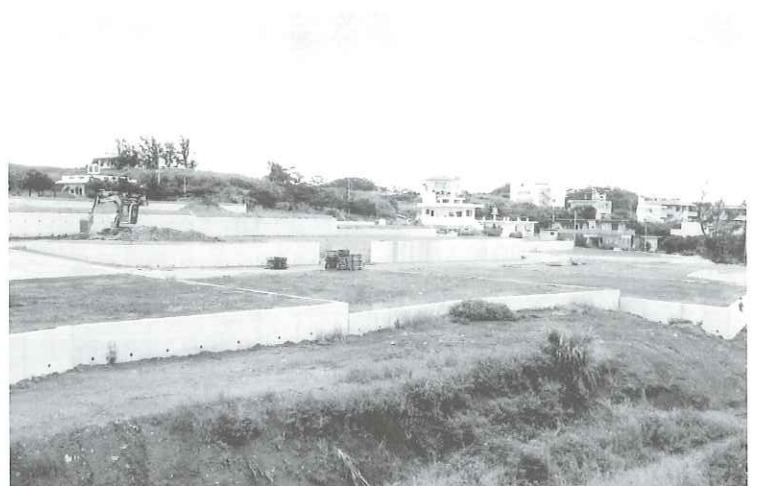
整備中の阿理第2期分譲地
