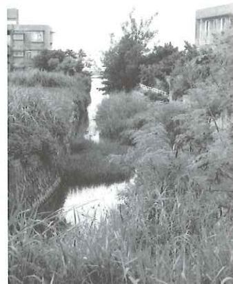
土砂が堆積している河川“ンナトウングア”
