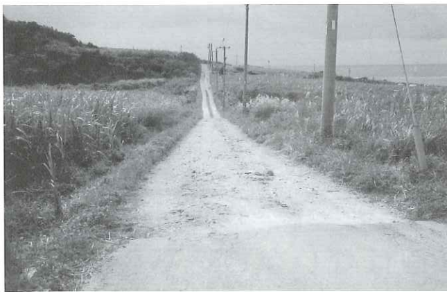
未整備の上野原線
