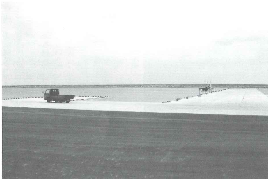
完成した新パス（兼城港）
