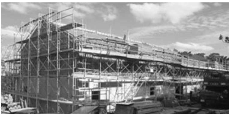
「風の帰る森」施設建設中
