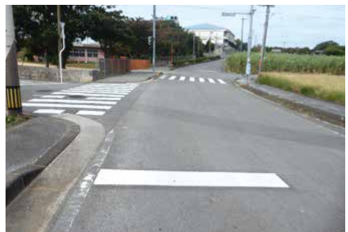
議会終了後に改善された道路(清水幼稚園前)
