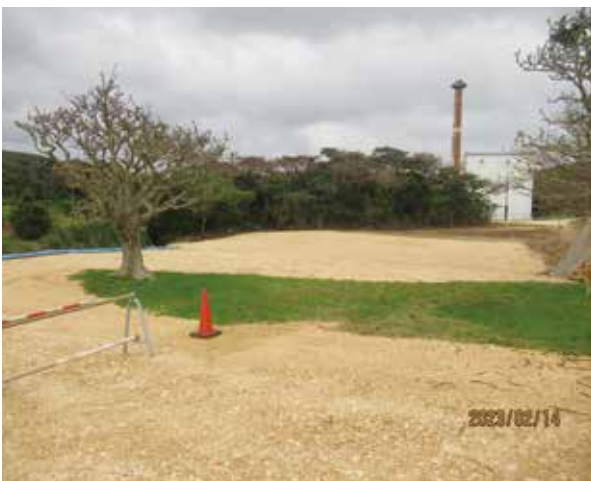
建設計画が進められている旧火葬場跡地
