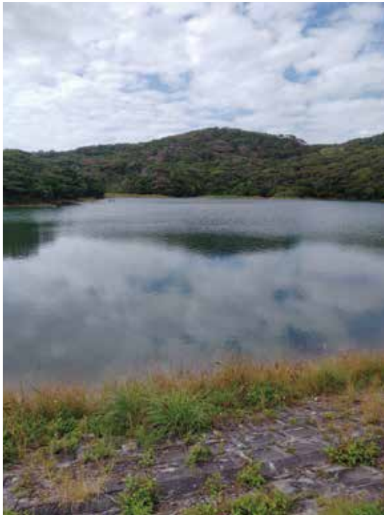
早期給水再開が求められている本庄池(字真謝)
