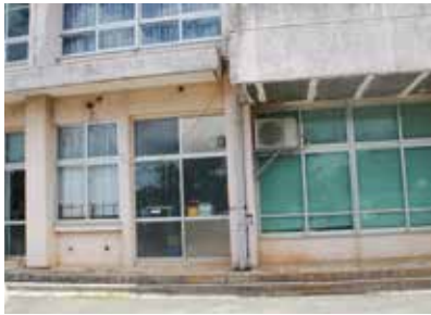
耐震補強工事予定の清水小学校舎
