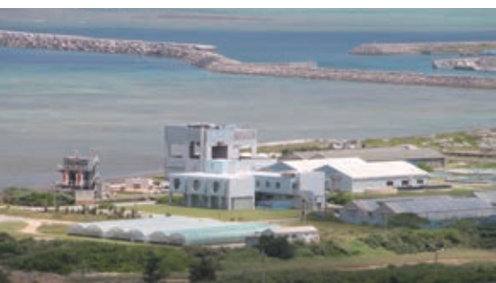
増設計画が進められる海洋深層水関連施設
